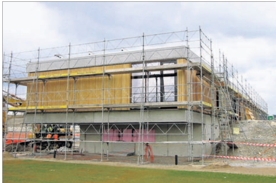
Bereits diesen Sommer kann das neue Vereins- und Garderobengebäude im Gries in Betrieb genommen werden.
