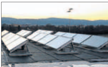
Sonnenkollektoren für Warmwasser.
