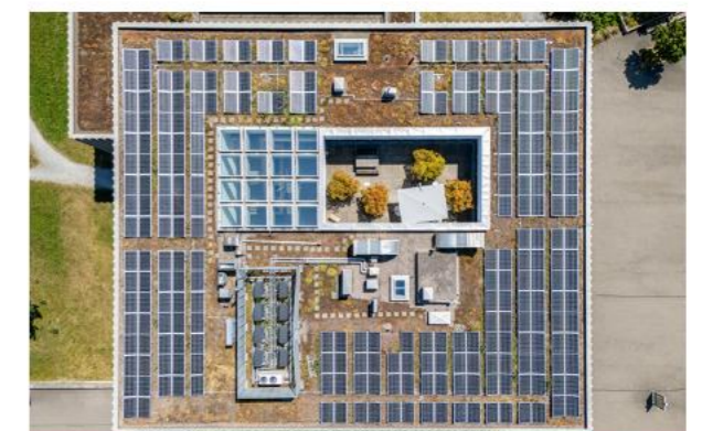
Drohnenaufnahme der PV-Anlage auf dem Gemeindehaus
