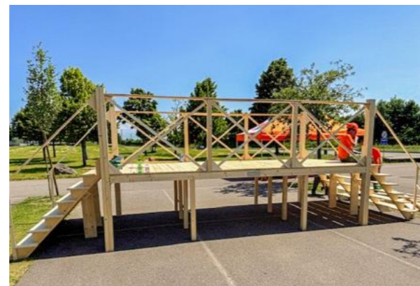
Die Zivilschützer bauten die Holzbrücke für den Sicherheitstag auf
