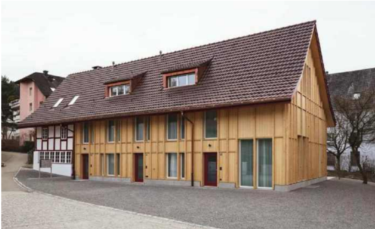
Ersatzneubau Scheune & Sanierung Bauernhaus in Schlieren, Singer Bänzinger Architekten
