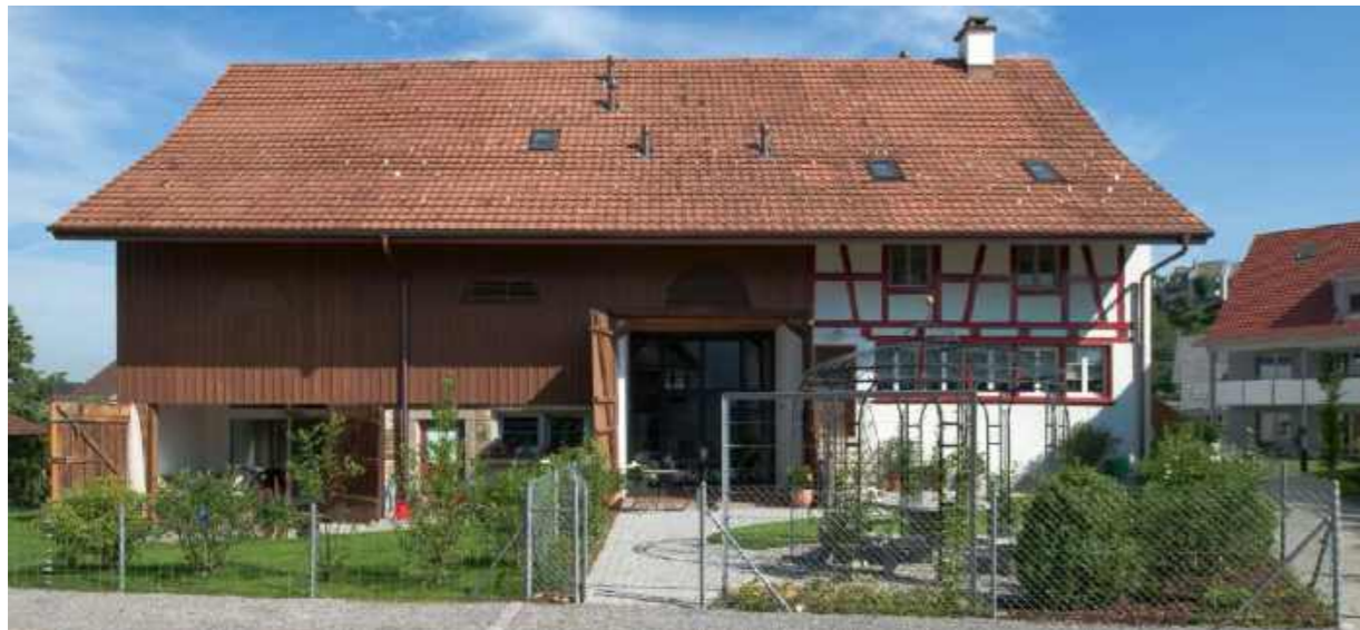
Umgebautes Bauernhaus in Volketswil
