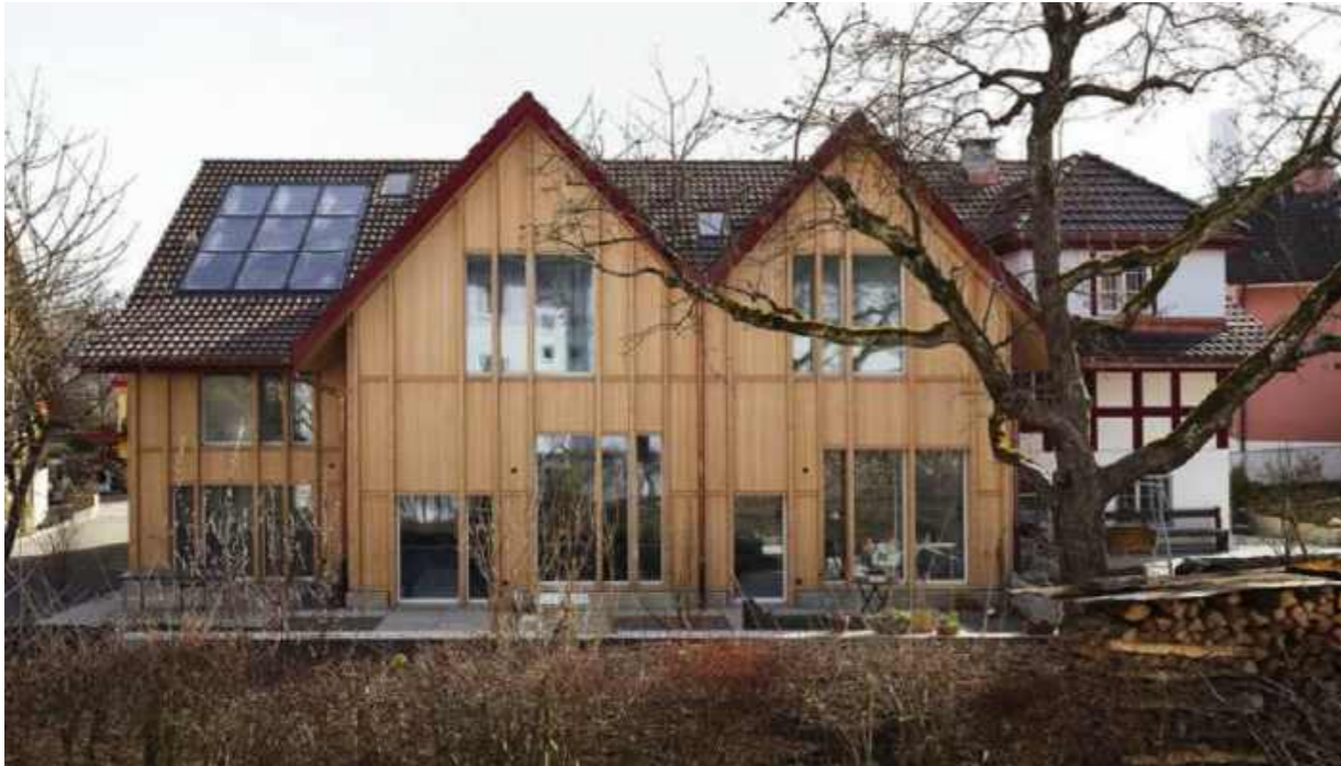
Ersatzneubau Scheune & Sanierung Bauernhaus in Schlieren, Singer Bänzinger Architekten
