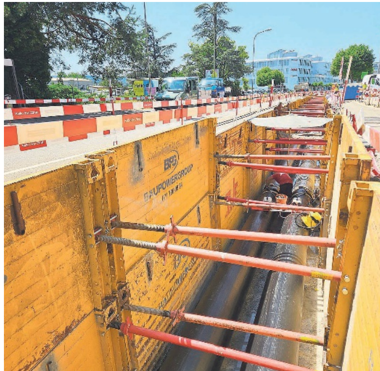
Bau der Leitungen für den Energieverbund der Energie 360° an der Industriestrasse in Volketswil.
