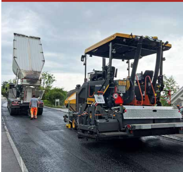
Belageeinbau an der Huzlenstrasse
