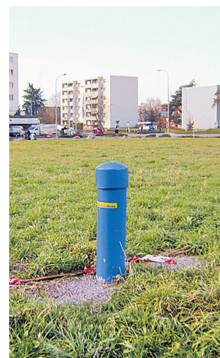
Abklärungen über das Grundwasservorkommen mit Rohrbohrungen.
